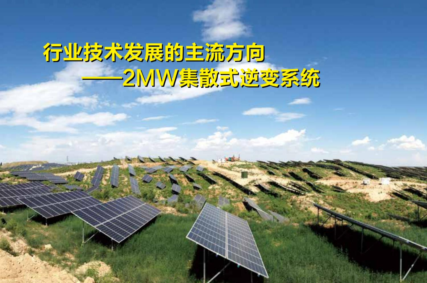
PV光伏组件通过22~26个集散式汇流箱分别汇集后连接到2台1MW的集散式逆变器，逆变器的输出通过1台2000kVA的双分裂变压器升压并网。
