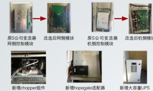
(图1 变流器硬件改造)
