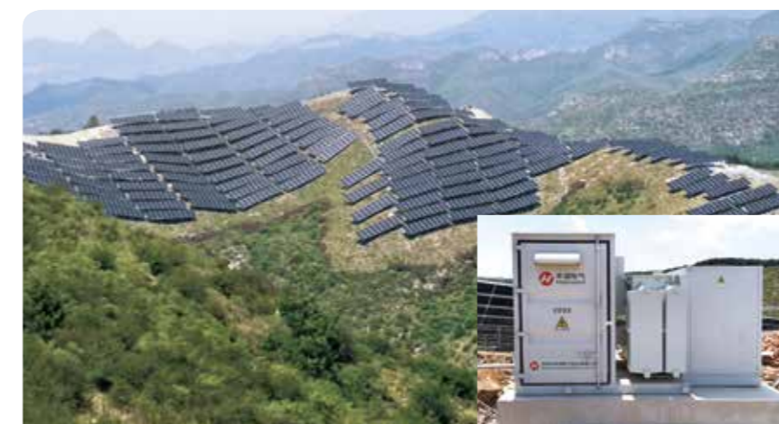
长治光伏发电技术领跑基地黎城155MW项目
