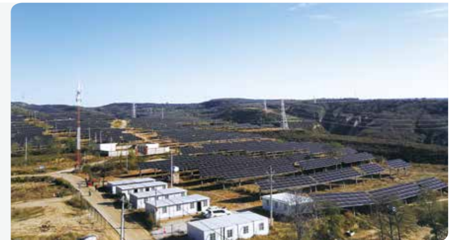
> 铜川光伏技术领跑基地宜君峡光250MW光伏项目
