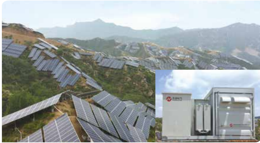
河北保定阜平县城南庄镇 30MW扶贫光伏项目
